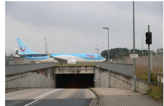
Ein Tunnel unterquert seit 2010 den Flughafen
