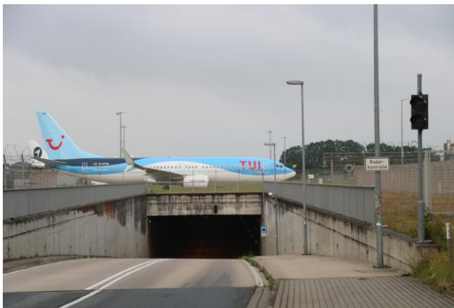
Ein Tunnel unterquert seit 2010 den Flughafen
